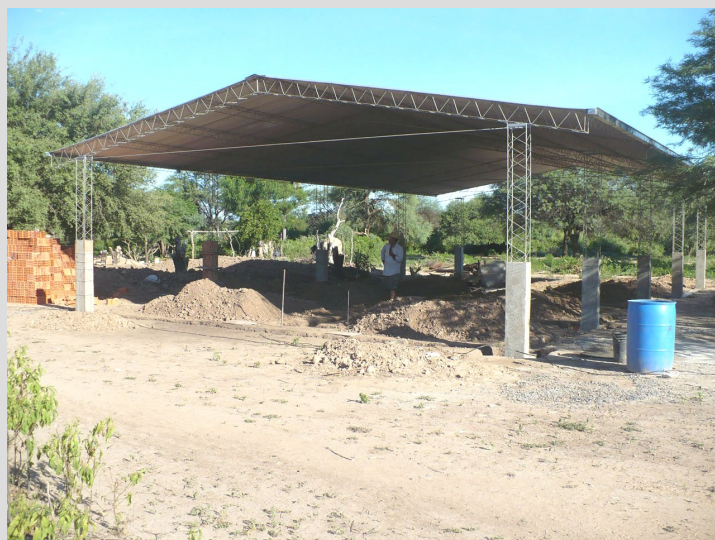
Centro Comunitario de Fischat en proceso de construcción.
